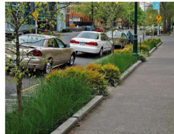
Figur 35: Eksempel på regnbred (Portland)
