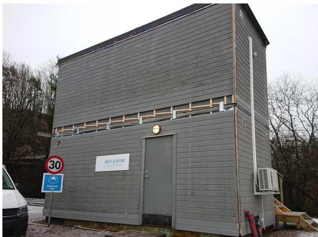
Figur 16: Modulbasert renseanlegg ved Borge pukkverk deponi levert av Mivanor
