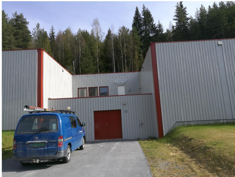
Figur 5. Bilde av høydebassengene ved Østenforskogen, hvor vannet blir behandlet før det går ut på forsyningsnettet.
