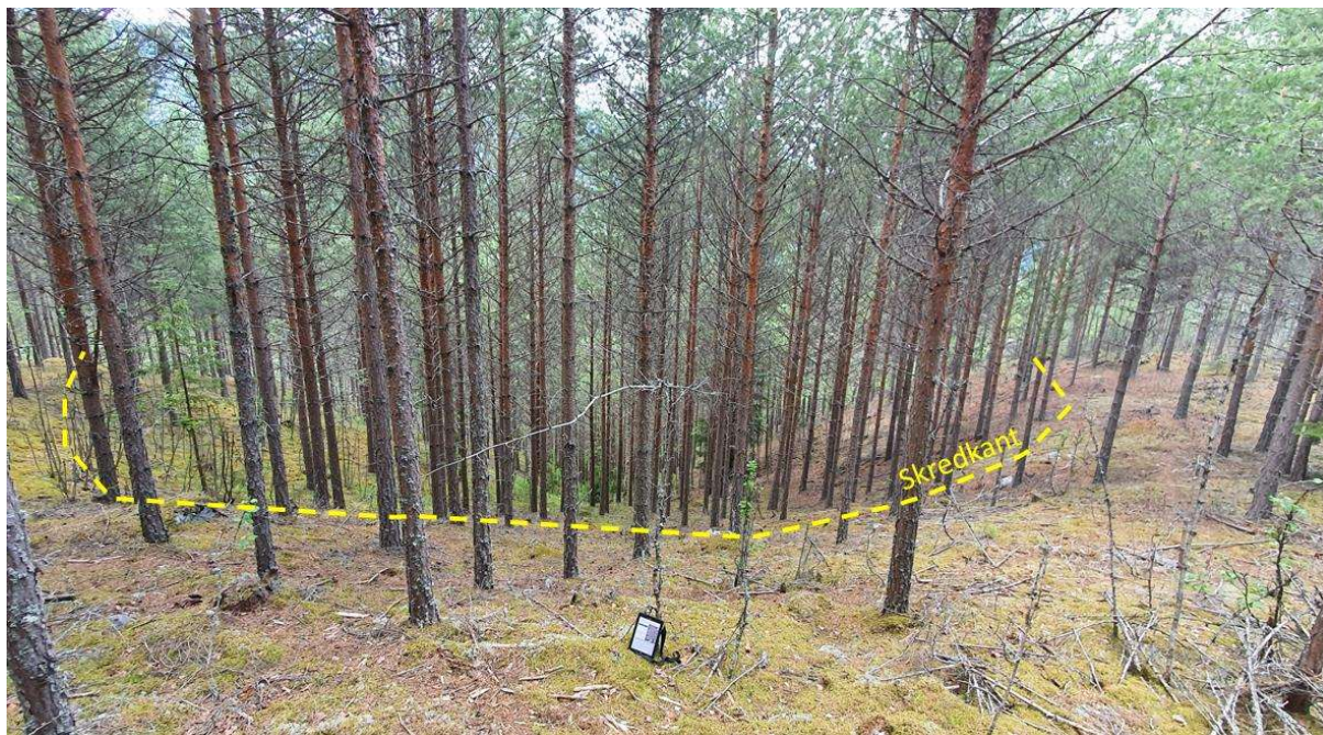
Figur 10: Oversiktsfoto av skredkant for tidligere jordskred rett øst for planområdet.
