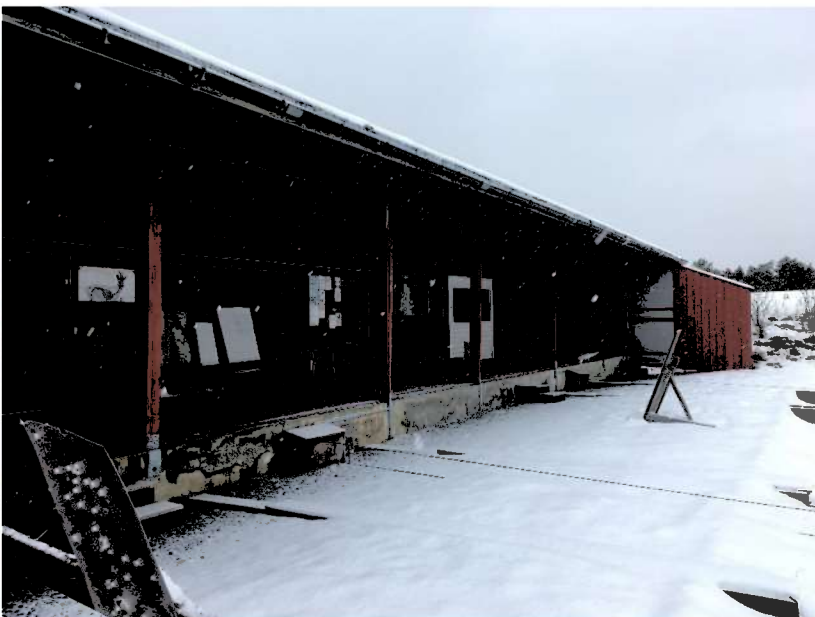
Figur 4: Eksisterende standplass. Kilde: COWI, 2019.
