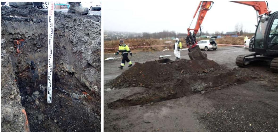
Figur 9. Bilde til venstre viser prøvesjakt A1, og bilde til høyre viser graving av prøvesjakt A2.
