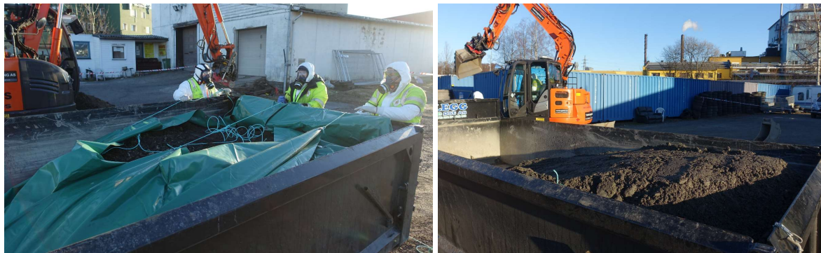
Figur 8. De utgravde massene ble pakket inn i presenning (bilde til venstre), dekket over med presenning, og det ble lagt et lass med ren jord over, for å sikre at det ikke ville dette av forurensete masser under transport til godkjent mottak.
