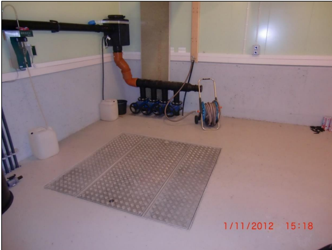
Figur 19: Utløpsmanifold til sandfilterbassenger (svart med ventilratt), samt prøvetaking av inn- og utløp renseanlegg.
