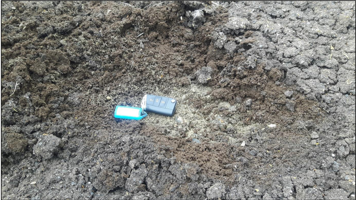
Figur 21: Opptørket slamlag på bunn av midtre basseng, bilde fra juni 2022. Slamtykkelsen er ca 5 cm.
