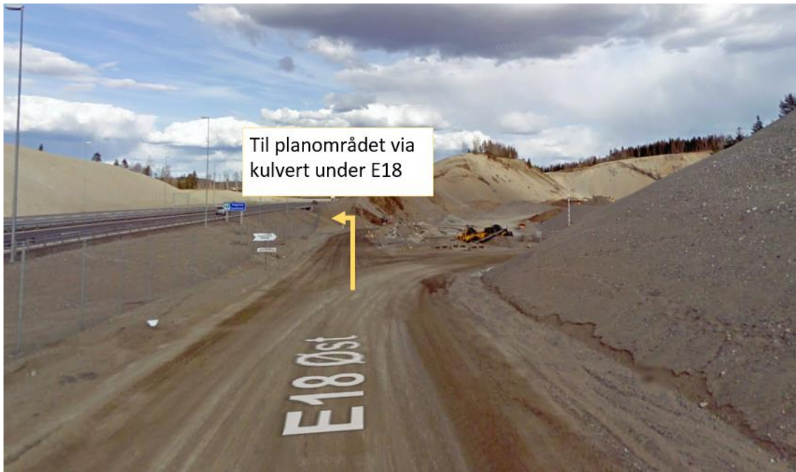
Figur 4: Gatebilde av Brennemostien (kilde: Google Street View)
