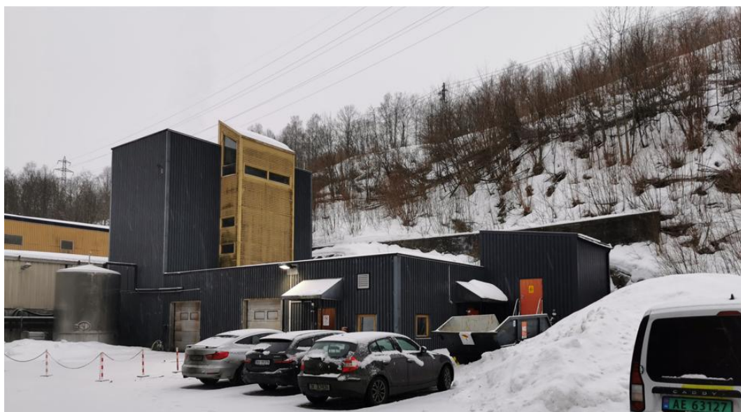
Figur 24. Renseanlegget ved Mills.
