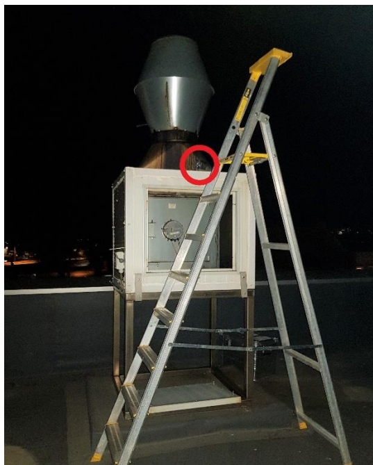
Figur 2. Plassering prøvepunkt på skorstein.
