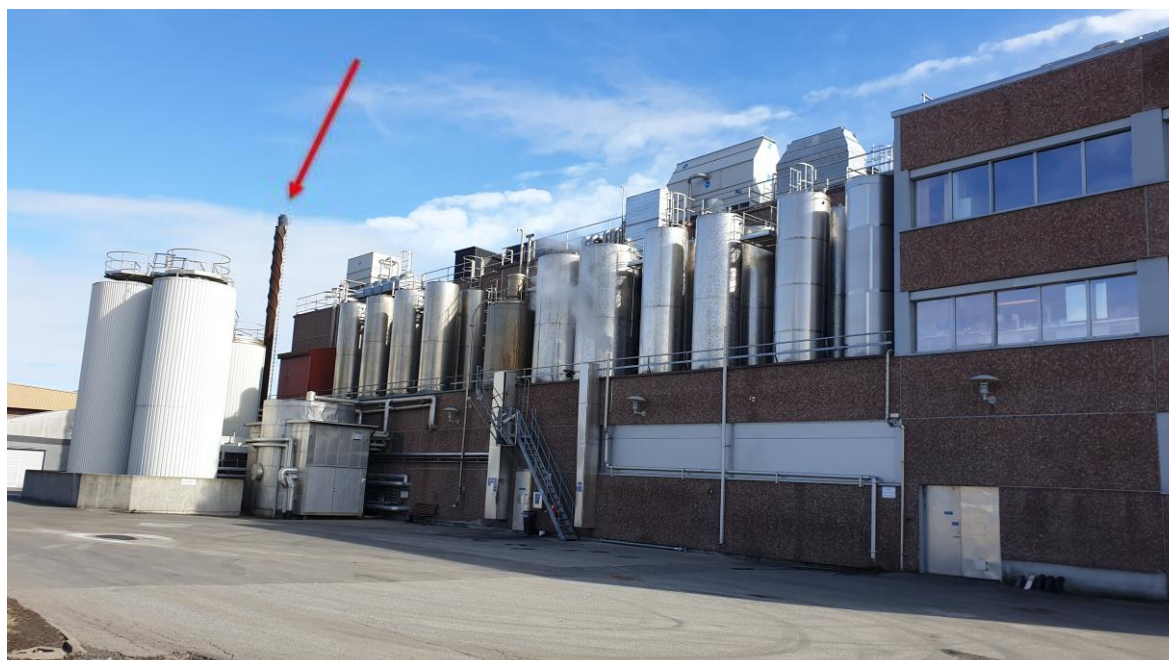
Figur 2-2. Bildet viser fyrhuspipa i bakgrunnen (rød pil) og diverse tanker for lagring av råvarer i forgrunnen.
