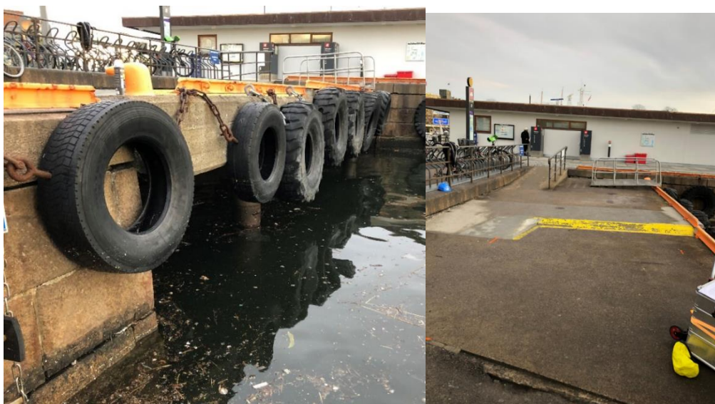
Figur 1-3: Bilder fra befaring av Rådhusbrygge 5. Kilde: Sweco Norge AS.
