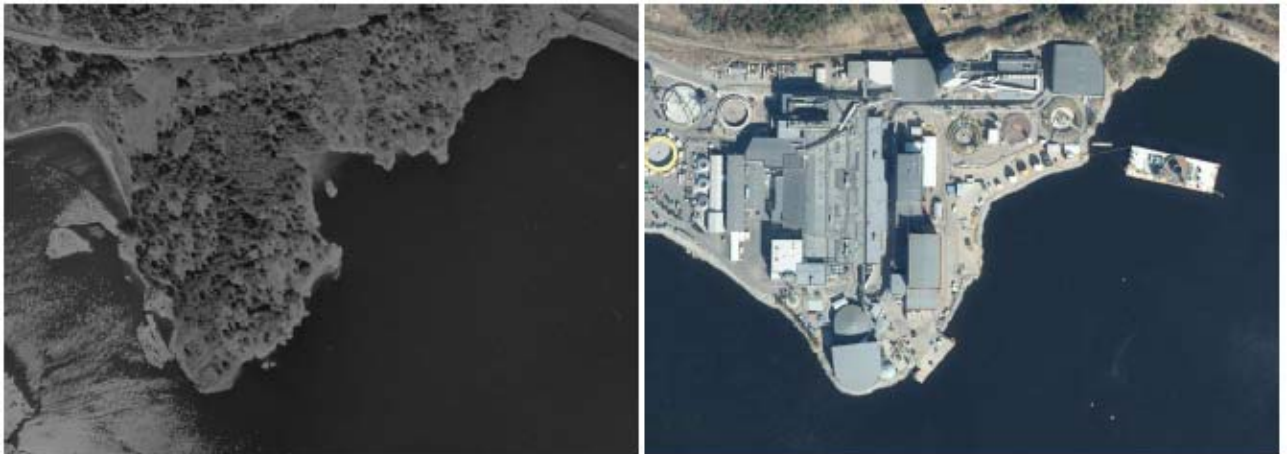
Figur 2: Flyfoto fra 1962 og fra 2019 av området til Nexans i Halden som viser utvikling og omfang av dagens fylling.
