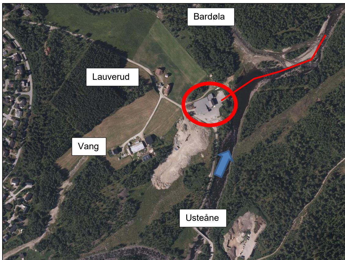
Figur 23. Flyfoto av Geilo renseanlegg. Renseanlegg markert med rød sirkel, utløp vist med rød strek.
