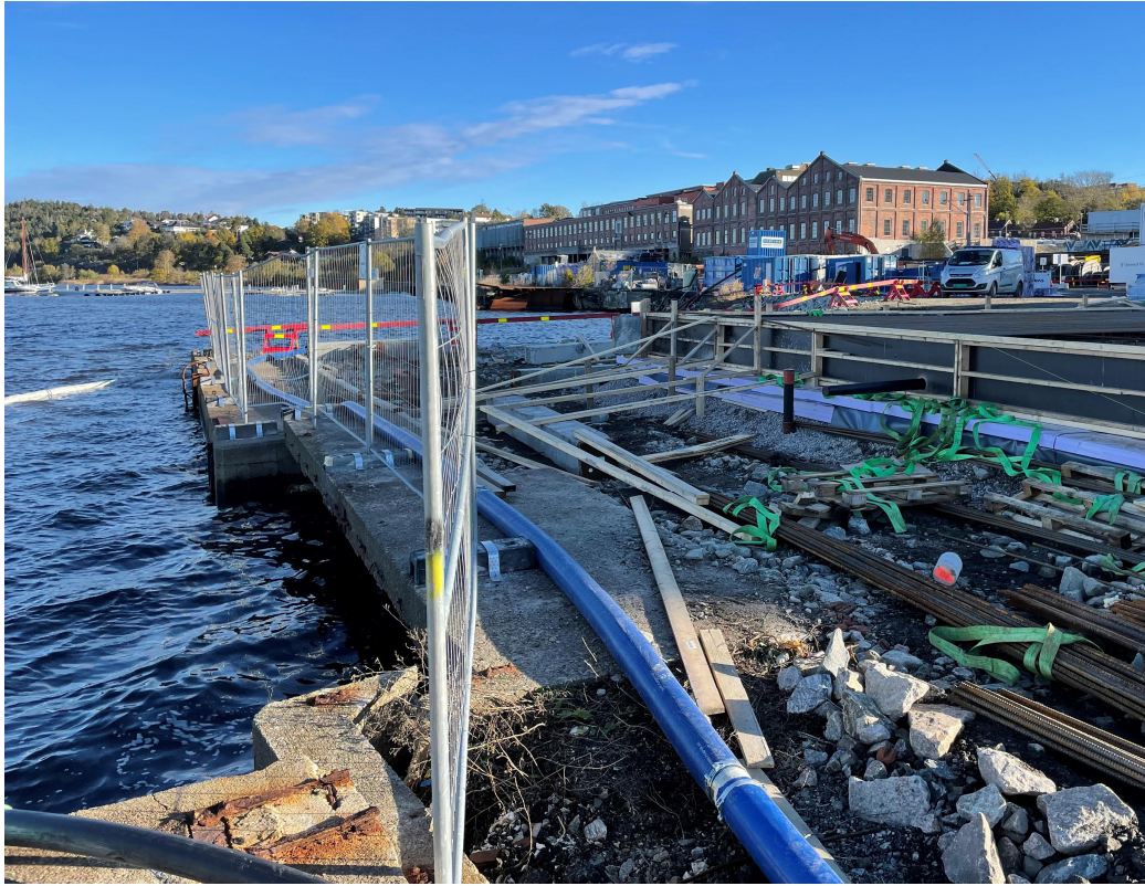
Figur 3-8: Område sør, bilde mot nord, 2021, viser trang passasje ved oppførende bygg.
