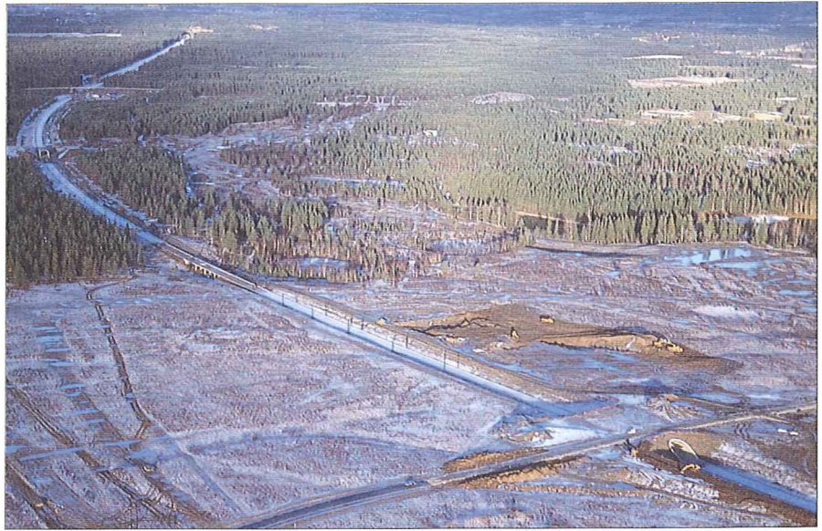
Gardermobanen gjennom Trandumskogen. Romerikslettas høyeste tetthet av elg finnes her. På den åtte km lange strekningen fram til E6 tunnelinnslaget før Råholt bygges tre overganger og tre underganger. Flere av disse er dimensjonert spesielt med tanke på elg. Foto: Øystein Søbye.
