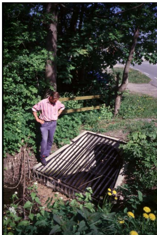
Fig. 4.11. Vandringshinder i nedre del av Arnestadbekken
