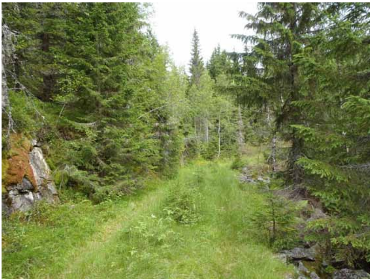
Gammel traktorvei fortsetter fra enden av skogsbilvei inn i området sør for Søttjernberga (Foto: Ragnhild Heimstad, Sweco Norge AS)
