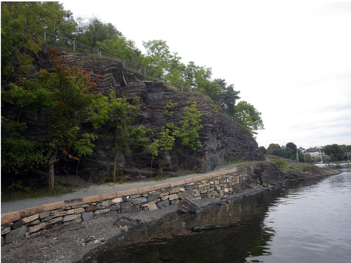
Figur 2. Markert kalkvegg sørøst for Rodeløkken, Bygdøy, Oslo kommune. Foto: Harald Bratli 2014.
