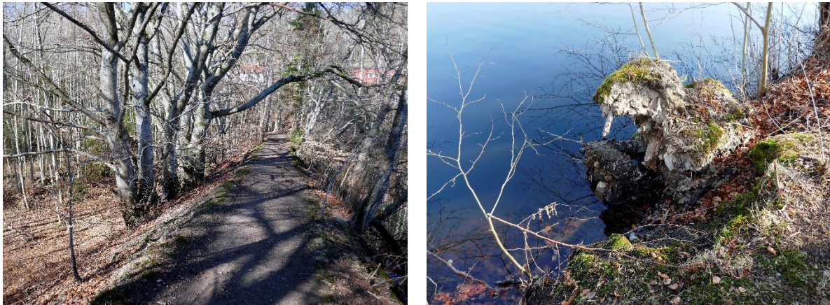
Figur 8. Damkronen med den store, plantede bøketrærne, og begynnende erosjon i damkronen på vannsiden som følge av vindfall inn i dammen.
