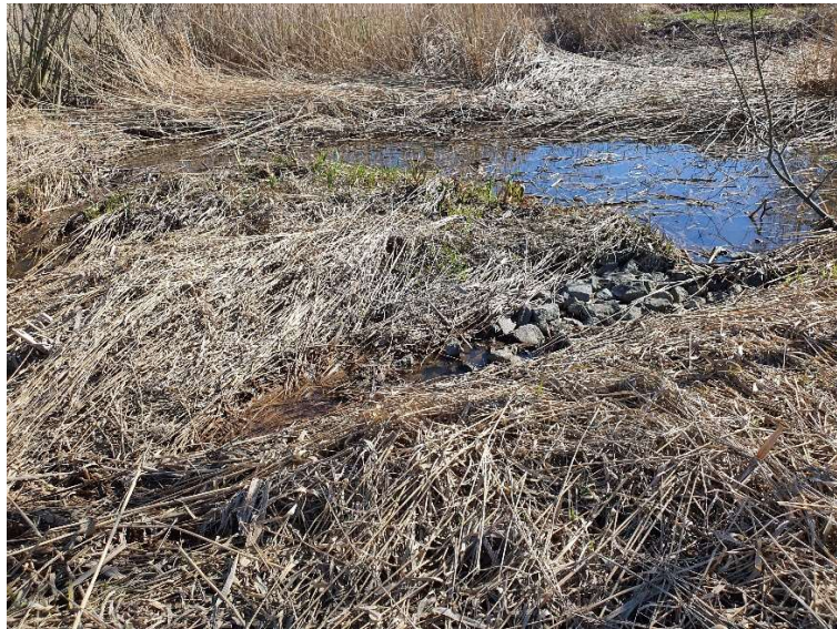
Terskel i fangdam ved utløp av Skirødbekken
