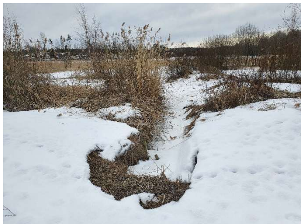
Utløp fra fangdam mot sjøen må ofte renses for siv og sedimenter
