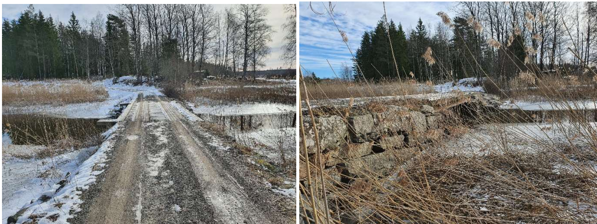
Bru over til Blixøya, eneste adkomst til arealene.
