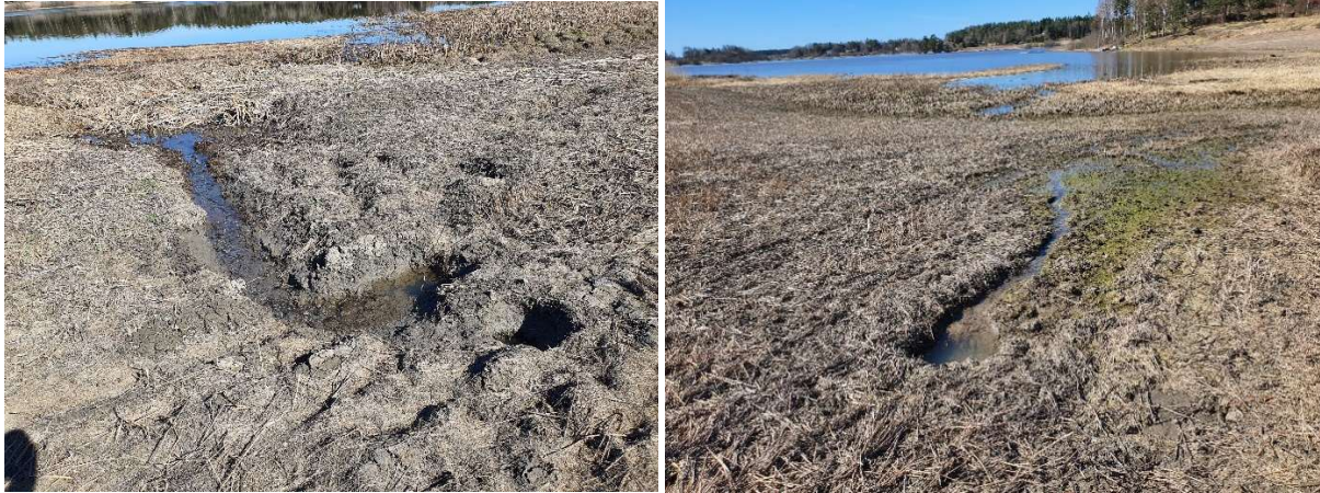
Synkehull, erosjon og fuktige partier årsaket av dykkede utløpsrør
