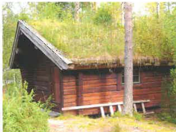
Bygning ved Ulveholtet. Foto: Øystein Røsok
