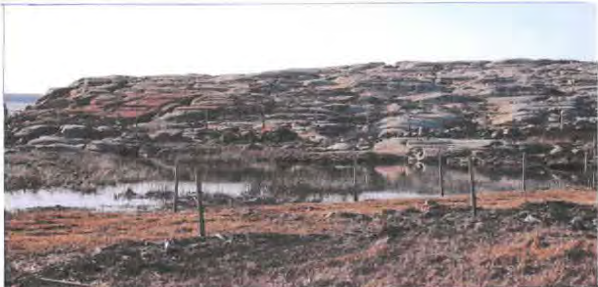
Figur 27. Skjellvik dam. Foto 24.3.2012
