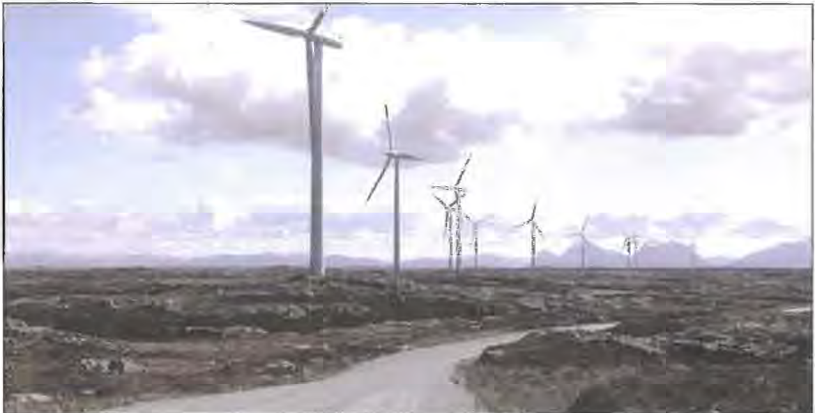
Figur 3. Smøla vindkraftverk med internveger og vindturbiner. Vegene har normalt en bredde på ca. 5 m og grusdekke. Adkomst- og internvegene på Kjølen vindpark vil også kunne brukes av grunneierne i forbindelse med skogsdrift.
