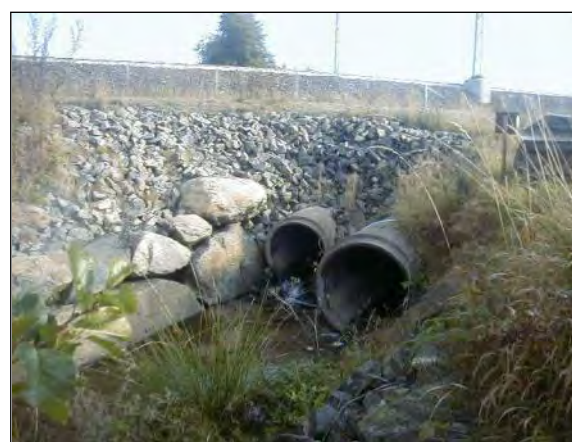
Jernbanekulvertene. Bilde tatt 01.10.04.
