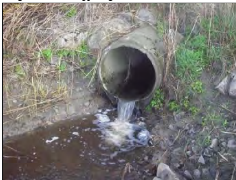
Fig. 5. Kulvert ved st. 2.
