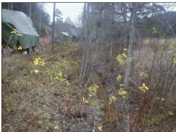
Fig. 4. Bekken sett fra veibrua og oppover.
