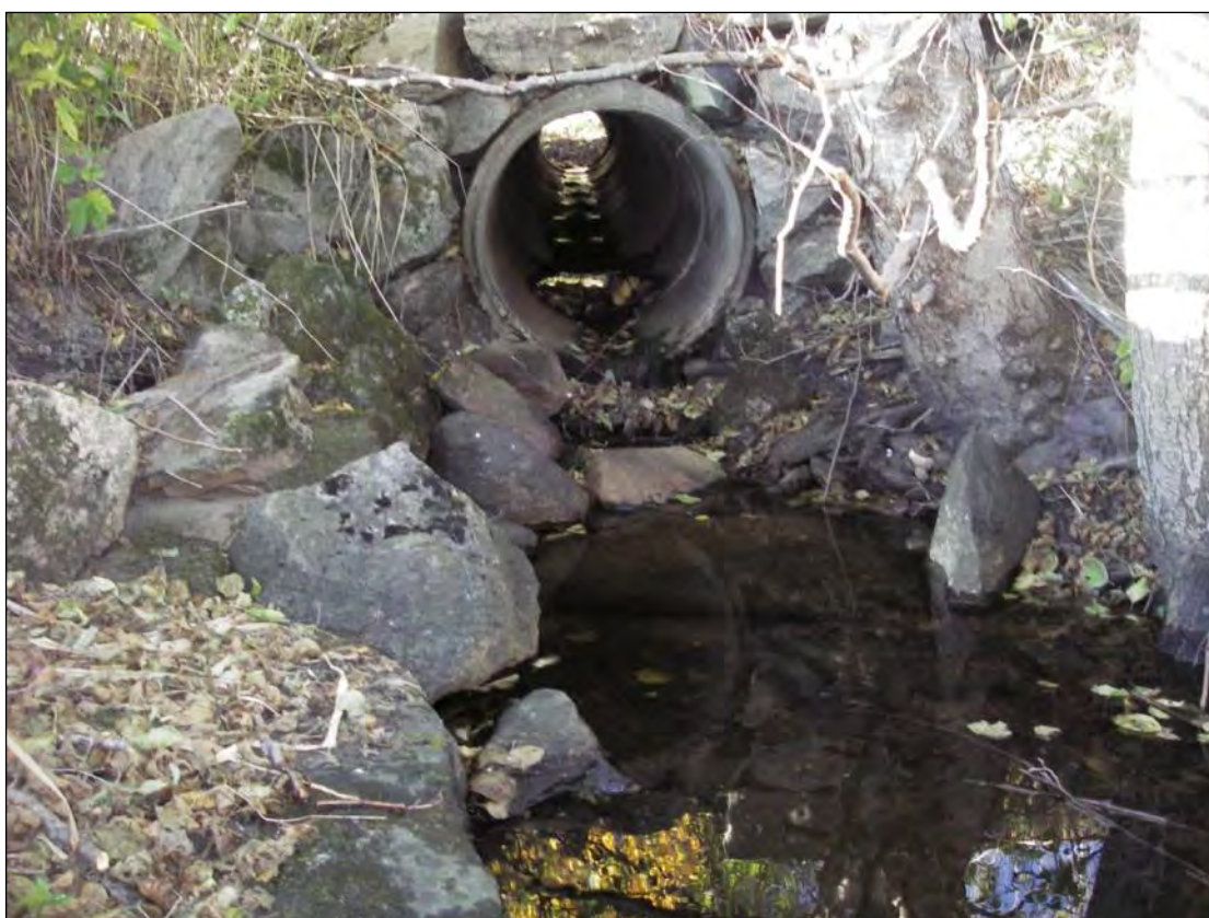
Fig.2. Kulverten under riksveien.
