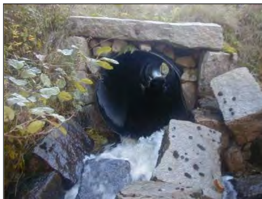
Fig. 5. Kulvert under veibru.
