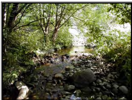
Fig 1. Fra nedre kulvert og oppover.
