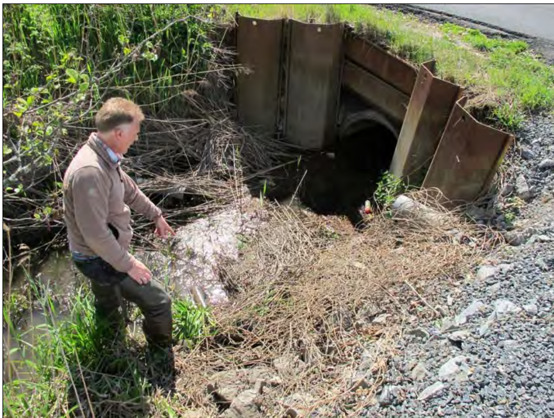
Fig. 2. Kulverten under Haslevegen hvor et mulig utslipp kan ha skjedd.
