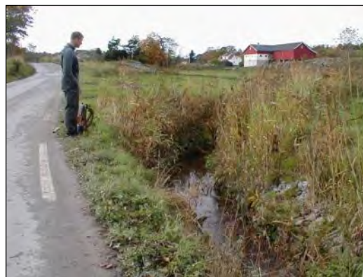
Fig. 4. Holtebekken ovenfor kulvert.
