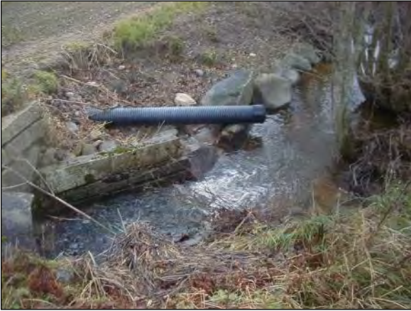
Fig. 2. Utløpet ved 2. lukking.
