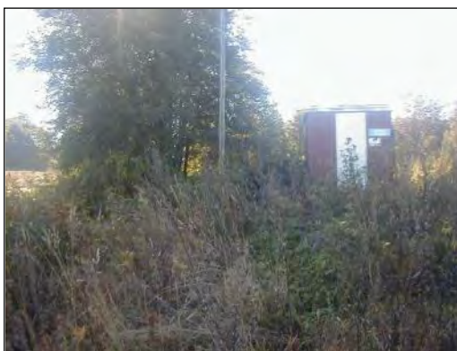
Fig. 6. Pumpehuset nederst ved utløpet.
