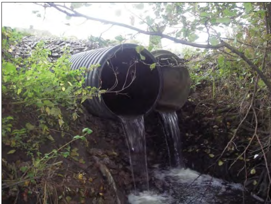
Fig. 7. Effektivt vandringshinder for fisk i Holmebekken under Rv. 112.
