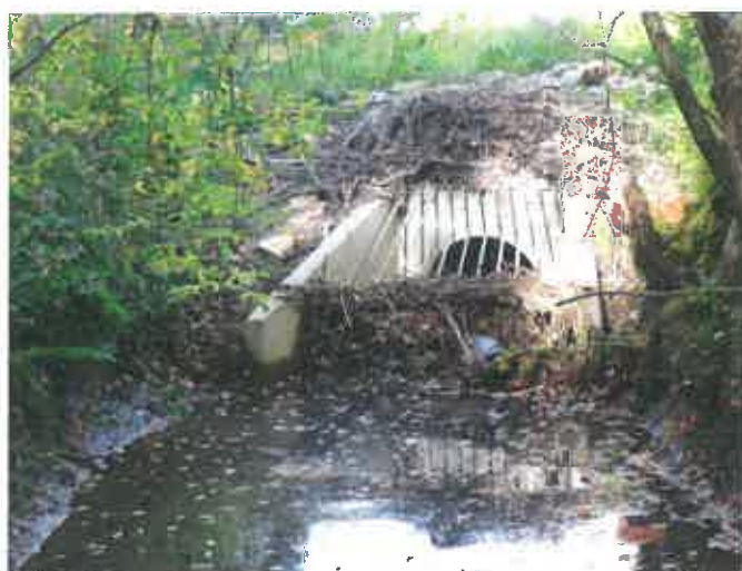
Bilde 13. Inntaket til kulverten som går under Vikaneveien 209 har et gitter som fyller seg med kvist som kan hindre gytefisk å komme forbi.
