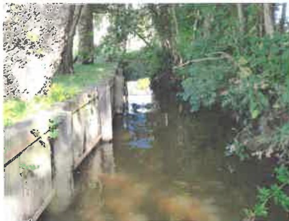
Bilde 1. Forbygning i Slevikbekkens nedre del. Generelt gir forbygning med stein bedre forhold for ørret p.g.a. mer skjul mellom steinene.
