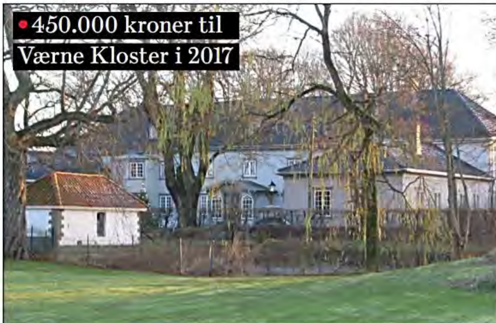
SAMARBEID: Fylkesmannen, fylkeskonservatoren og grunneierne skal nå samarbeide tett for å planlegge hva som skal gjøres av skjøtsel- og forvaltningsarbeid i det nyevalgte kulturlandskapet rundt Værne Kloster. FOTO: PAUL NORBERG
