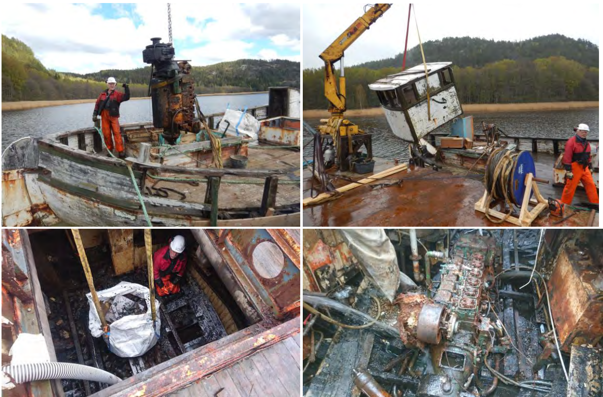
Figur 4. Fjerning av styrhuset, maskinen og ballasten lettet vraket med mange tonn. Mannen på bildet er Torstein Langgård – alltid like blid selv om tømmingen var en real grisejobb. Foto: Ola Wergeland Krog.
