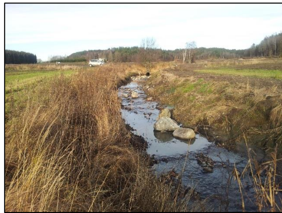
Fig.15. Det samme området etter tiltak. (NB! Bildet er tatt i motsatt retning av det forrige)
