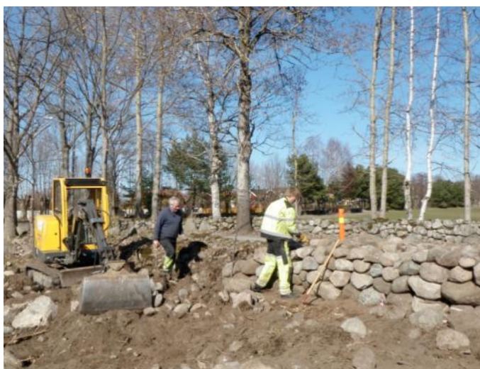
Figur 4 Flere steingjerder har behov for vedlikehold, og enkelte steder kreves omfattende arbeid. Her, restaurering av steingjerde ved Charlottenborg. Foto Gunnar Bjar
