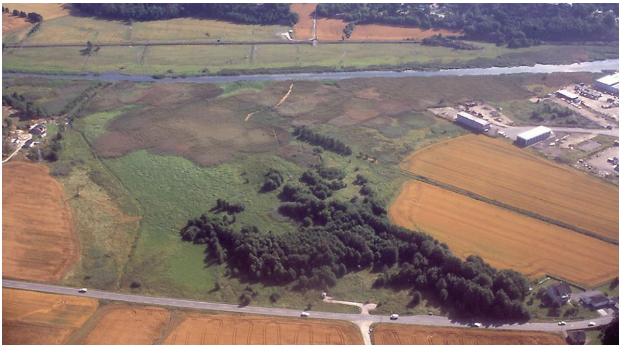
Skårakilen sett fra vest mot øst – riksveg 110 i forgrunnen
