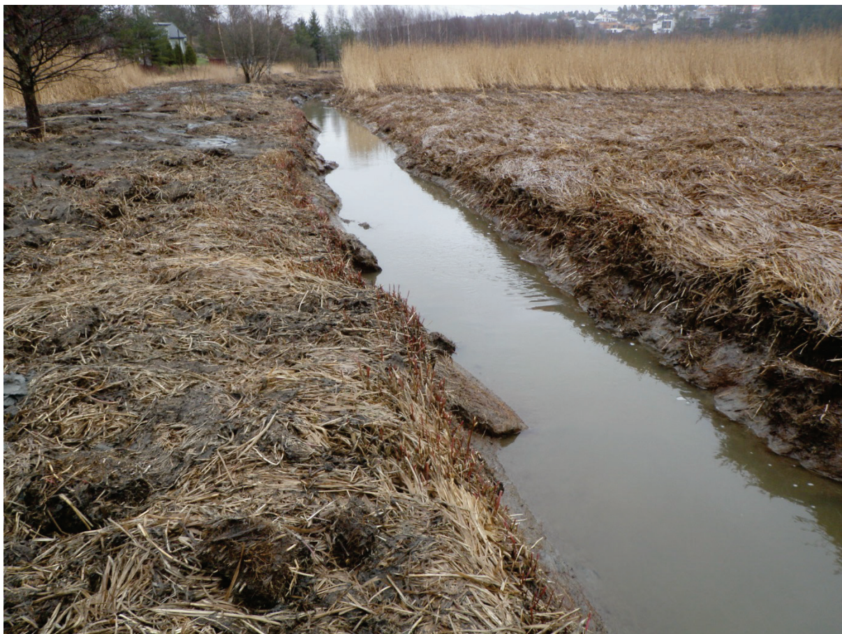
Vedlikehold av tidligere etablert grøfteavløp – massene er planert godt utover
