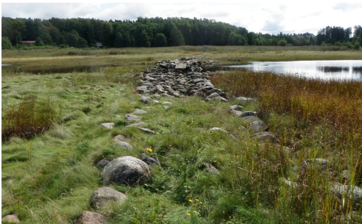
Den gamle Skjæløybrua slik den framstår i dag
