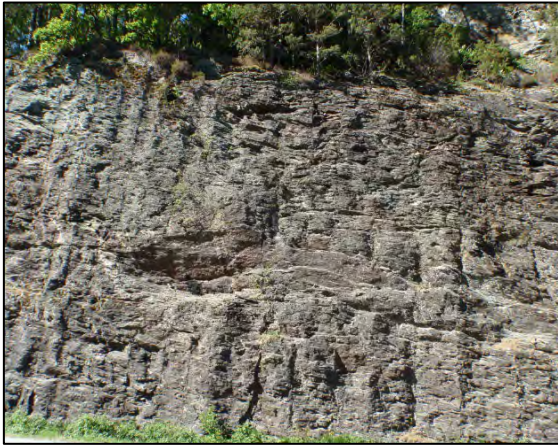
Fyllitt i veiskjæring ved Sandeidfjorden, Vindafjord (JOH).
