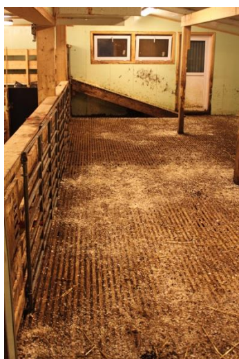
Bilde 4 og 5. Tv: Tett komposittgulv i et fjøs til geit i Nord-Norge. Foto: Marit Gåre. T.h. Et velfungerende komposittgulv med T-profiler. Foto: Grete H.M. Jørgensen.
