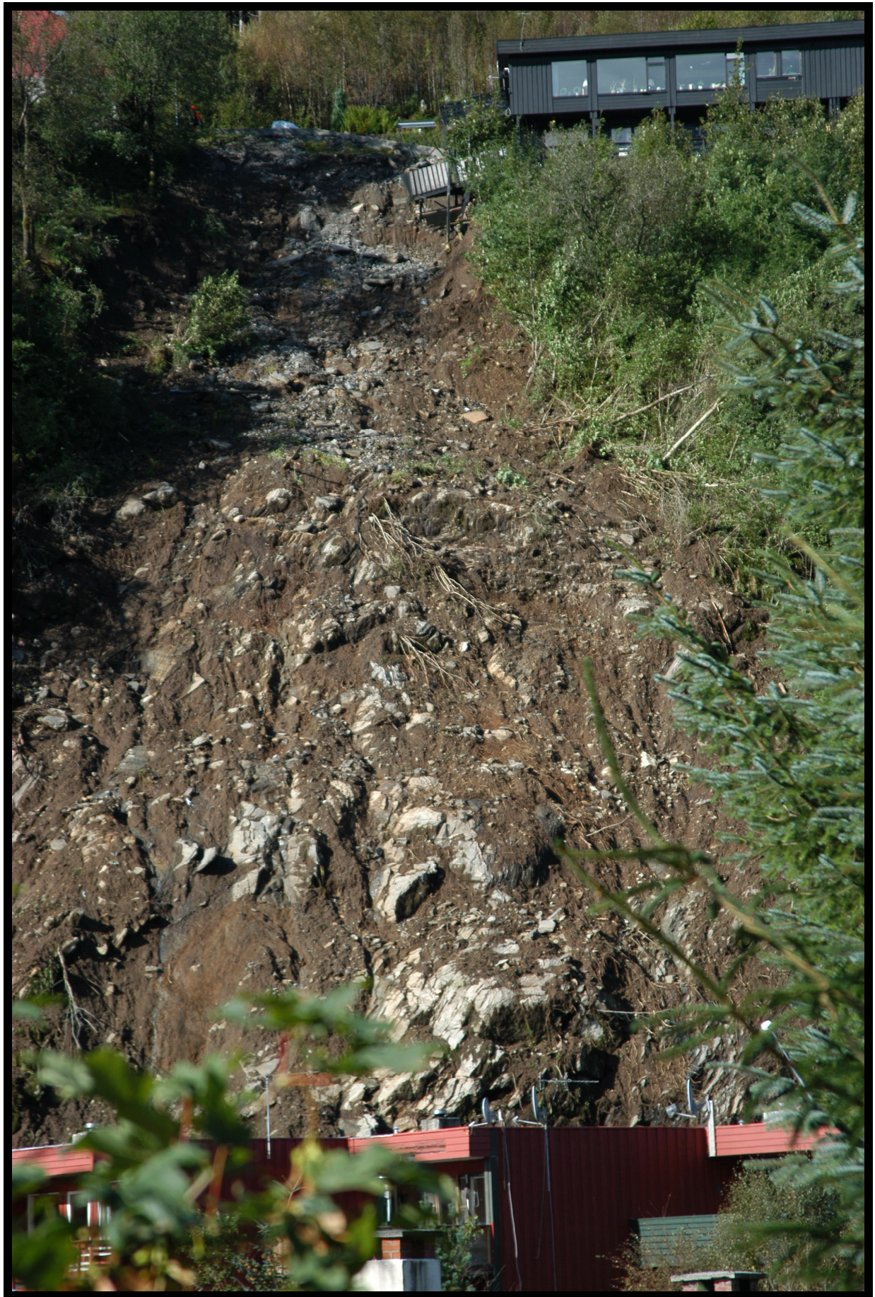
Jordras ved "Hatlestad terrasse" i Hordaland hvor menneskeliv gikk tapt. September 2005. Foto: Bergen kommune
