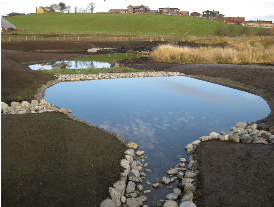
Figur 56: opne fordrygingsbassen ved Bryne, Time kommune (Foto: Vidar Ausen 2010).
