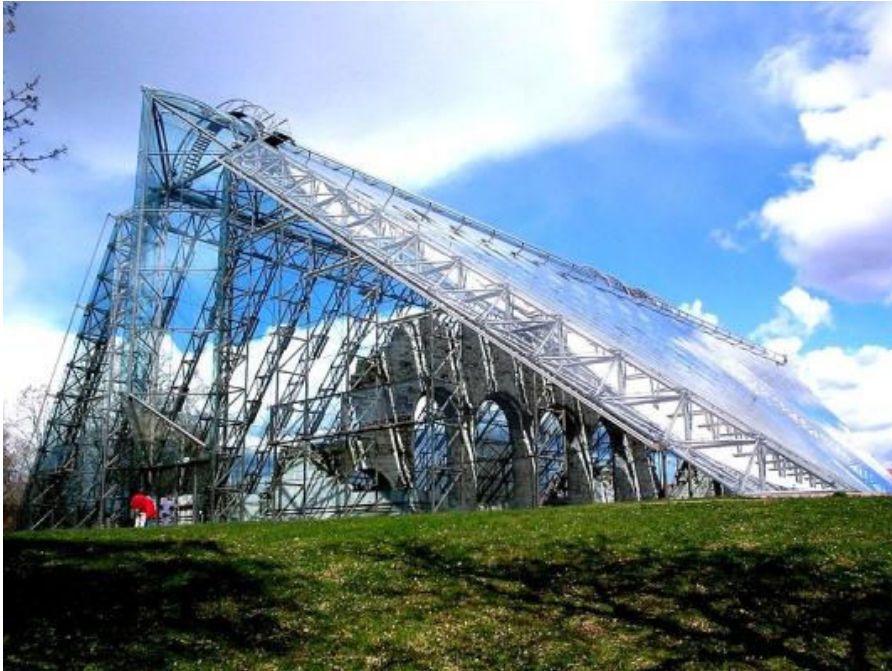
Figur 41: ”Hamardomen”, Ruiner etter gamle domkyrkja på Hamar blei pakka inn i vêrbeskyttande glaskonstruksjon i 1998. Foto: Torstein Frogner (wikipedia.no 2010)
