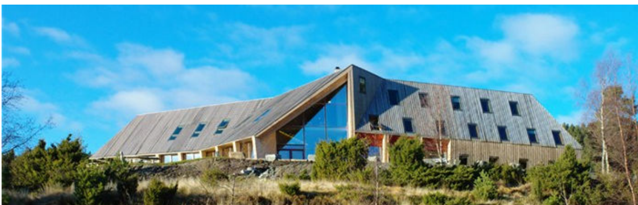
Figur 47: Preikestolen fjellstove ligg forma etter terrenget med sørvendte glasflater. Med si kompakte og isolerte bygningsform og tette klimaskjerm ligg stova i energiklasse A. Fjellstova fekk statens byggeskikkpris i 2009 (NAL ecobox 2010: Norwegian Wood - Preikestolen fjellstue www.arkitektur.no )
