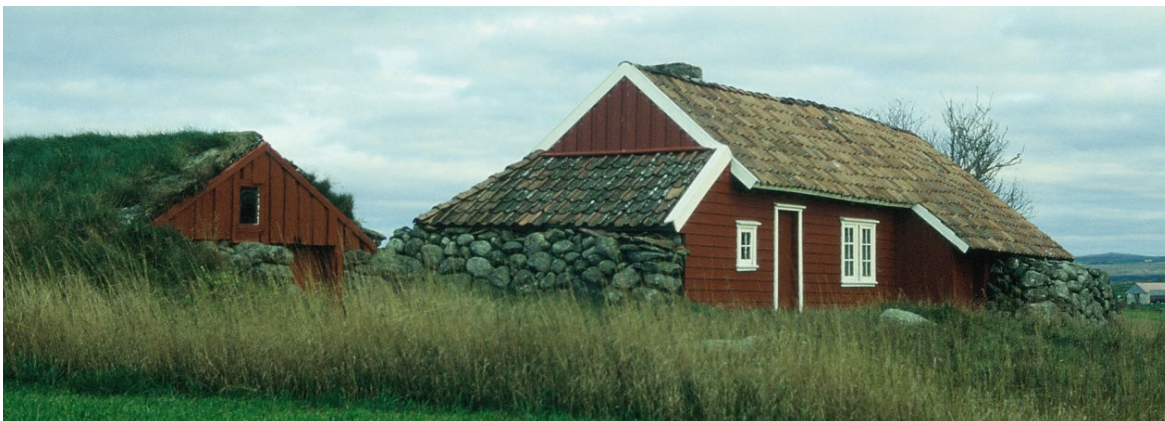
Figur 46: Jærhus (træe på Line, Time kommune ( Foto A. Lyshol, FMRO). Dei gamle jærhusa er godt tilpassa klimaet. Langveggen vender ut mot havet og gavlveggene står opp mot vinden. Husa er funksjonelle i dette klimaet, skutene vernar sjølve veggen mot vêr og vind, samstundes som skråtaket hjelper vinden opp og over taket.
