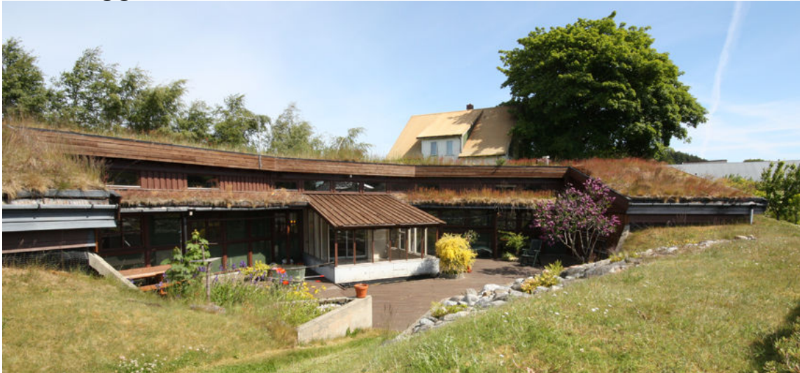
Figur 48: Eksempel, frå Randaberg. Jordhuset på Steindal gard er bygd ned i terrenget i ein byggestil meir utbreidd i USA; "earth shelter house". Huset frå 1982 er skjerma frå vêr og vind og sparer dermed energi (Steindal gard 2011).
