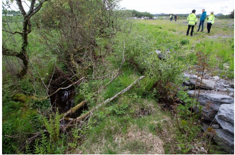
Bilete: syner kor tett massane med sprengstein er fylt inntil bekken
