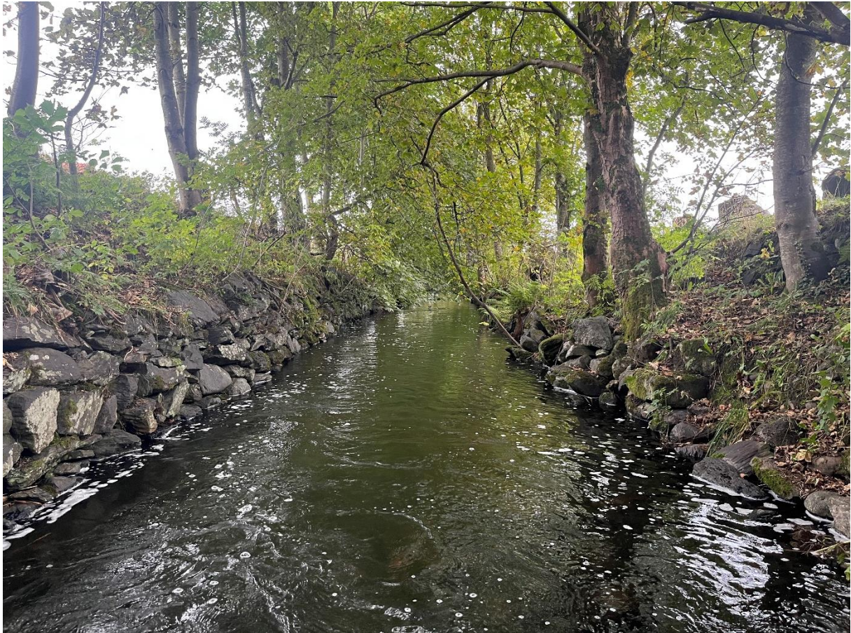
Figur 18. Lødd stein som erosjonssikring langs bekkebredden på begge sider av Kverneviksbekken nedstrøms demningen.
