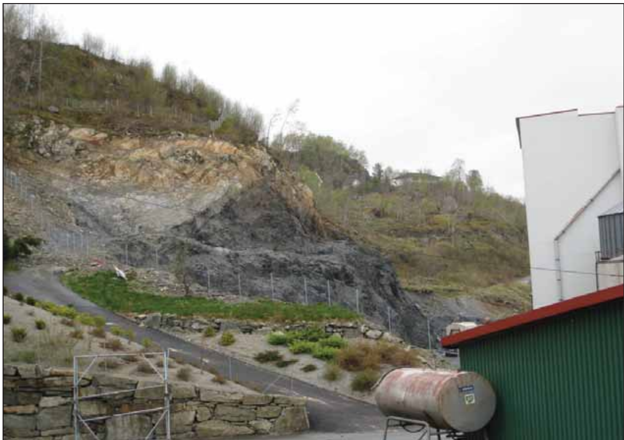
Figur 6.64:Foto tatt av bergskjæring ved befaring april 2008.
