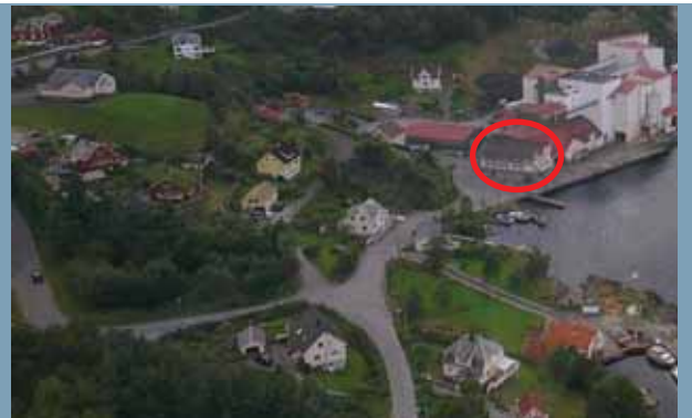
Figur 15: Dagens adkomst fra øst; kryss mellom Fv 523 og kommunal Fiskåveg, administrasjonsbygget med rød ring
