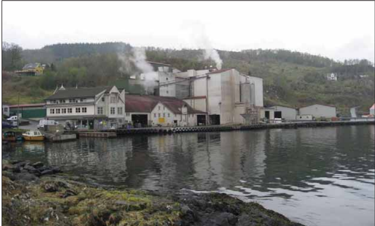
Figur 6.5: Foto fra neset rett øst for Fiskå Mølle. Det er etablert en ny skjæring som går opptil ca kote 35. Fra denne vinkelen er den ikke synlig i det hele tatt på grunn av den høye bygningsmassen i forkant)
