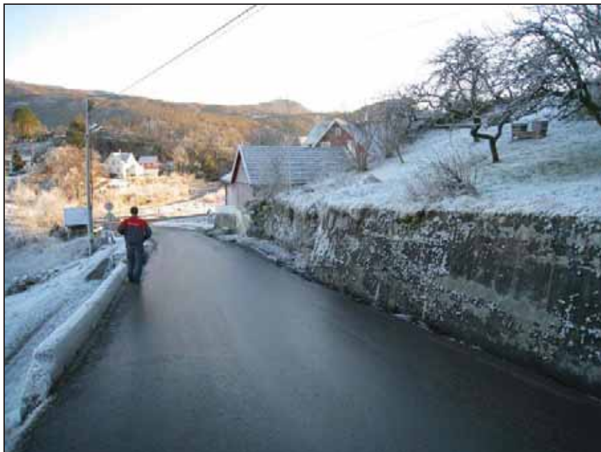
Figur 6.56: Foto av nederste del av stigningen, ved F4 og til kryss Fv 511
