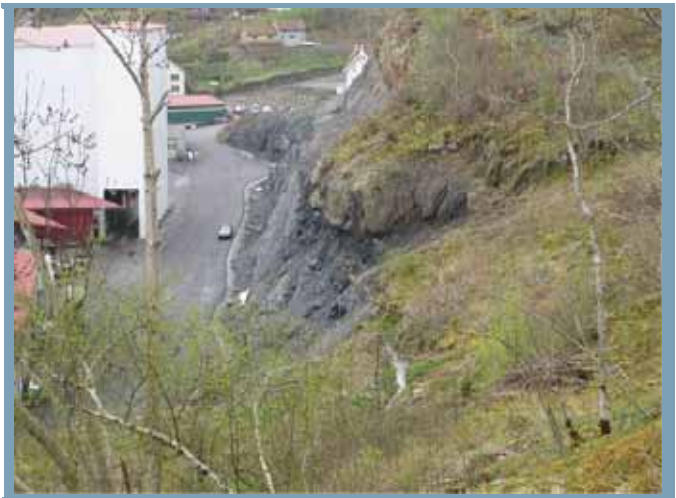
Figur 93: Foto av skjæring som viser fyllitt nede (mørkt) og gneis øverst, Norconsult AS 2008
