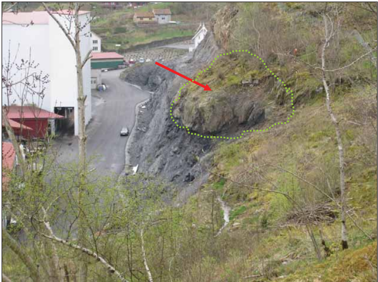
Figur 6.65: Foto av mulig ustabil bergparti sett på befaring april 2008.
