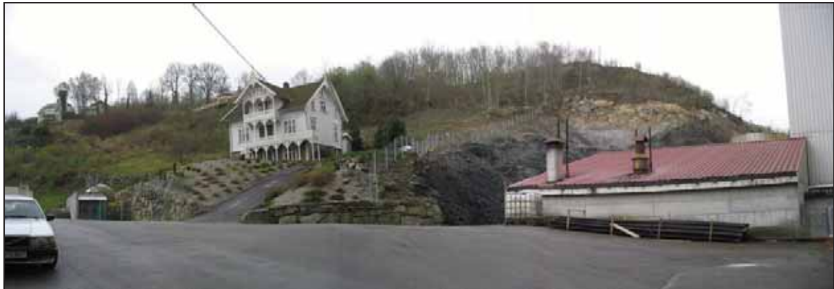
Figur 6.4 Foto av bygningen i sveitser-stil regulert til bevaring sett fra nord (industriområde)
