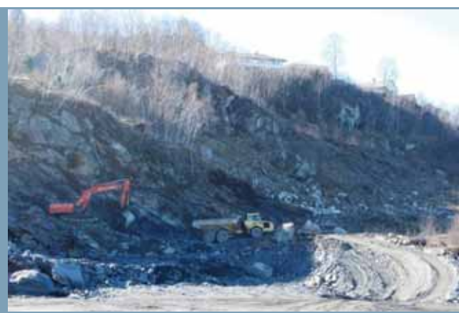
Figur 81: Arbeid med ny skjæring ca. 100 m øst for hytte på 7/8, Norconsult mars 2014
