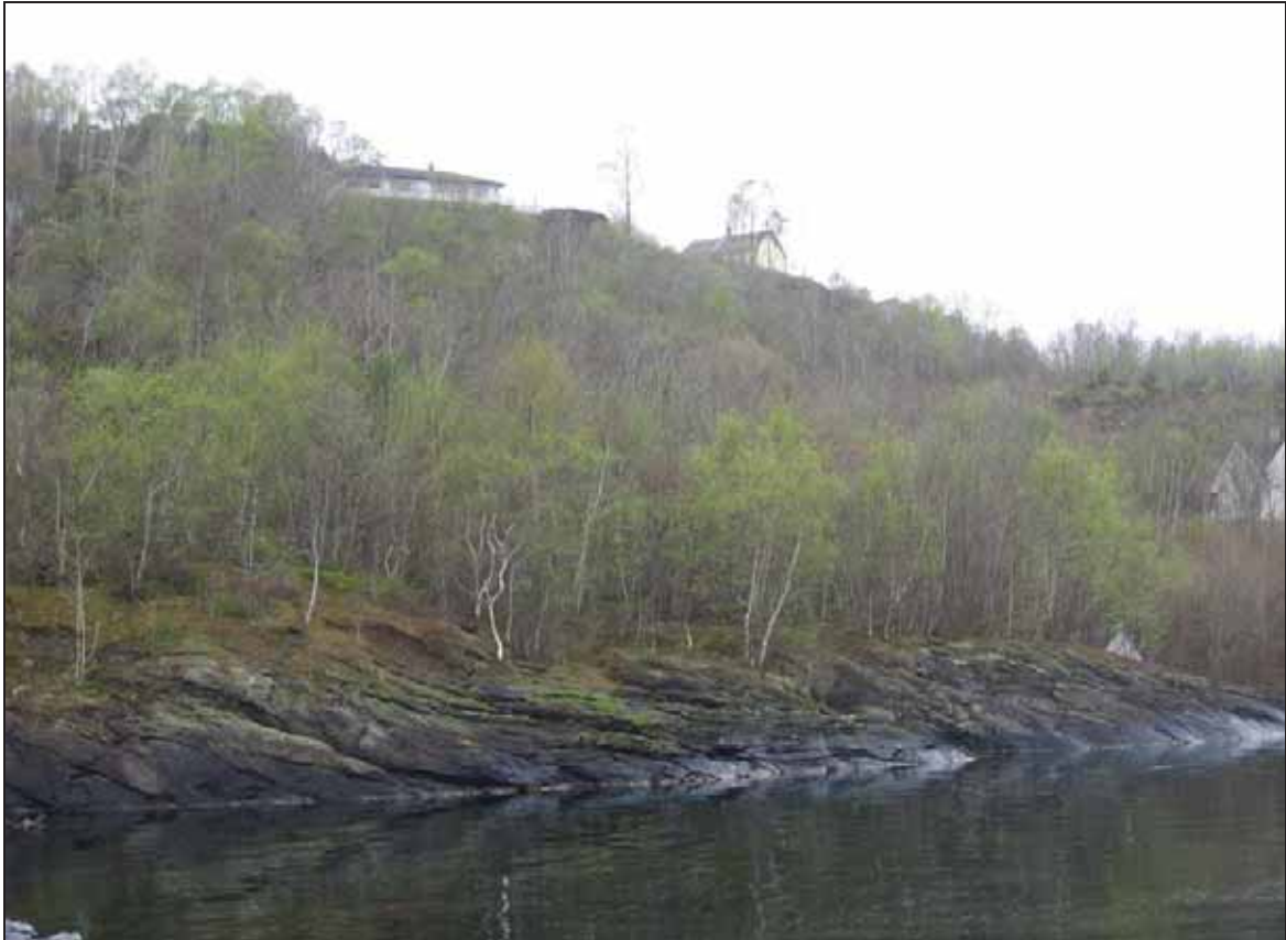
Figur 6.27: Foto viser sjøkanten i forlengelsen av dagens utfylling. Iht. reguleringsplanen foreslås nedbygging av gjenværende inntakt strandsone fra dagens fylling til reguleringsgrensen i øst.
