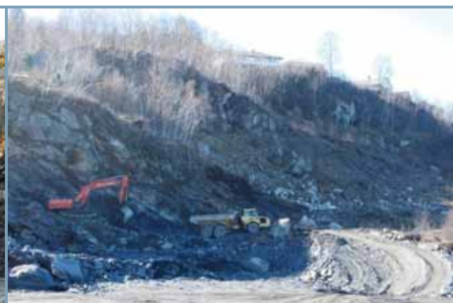
Figur 79: Arbeid med ny skjæring ca. 100 m øst for hytte på 7/8, Norconsult mars 2014
