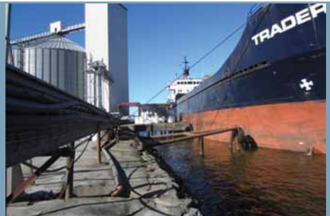
Figur 24: bakre fartøy fra forrige foto her ved den vestre kaien hvor gods kan transporteres automatisk på silo, Norconsult mars 2014
