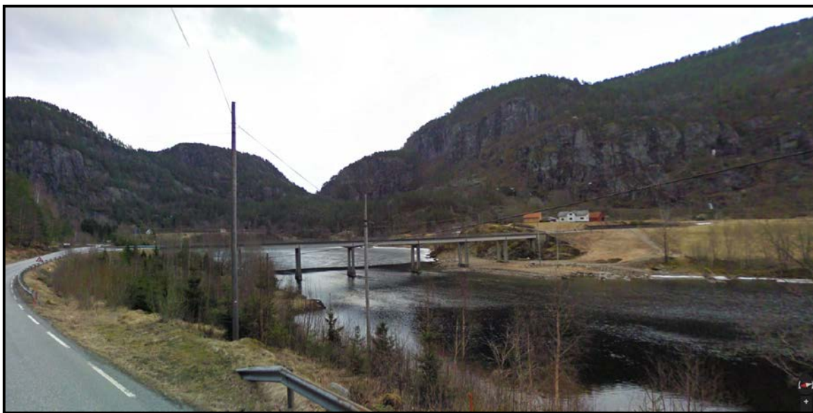
Figur 9 Helganes bru, bilde fra Google street view.
