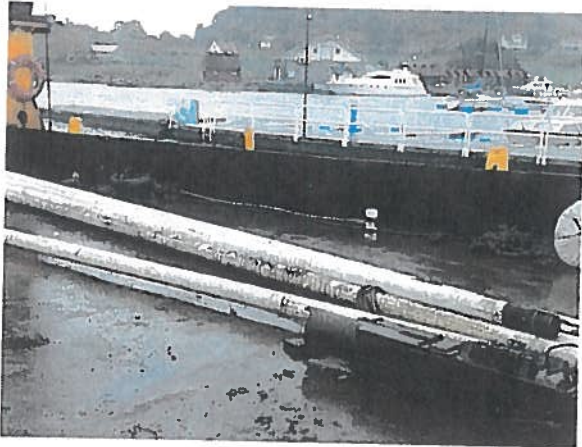
Pele-prøverør og pelingshammer ligger klar til montering i kran.
