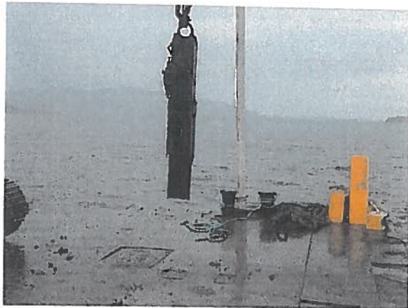
Pele-hammeren, ca 1,2 tonn heises på plass på toppen av prøverøret.
