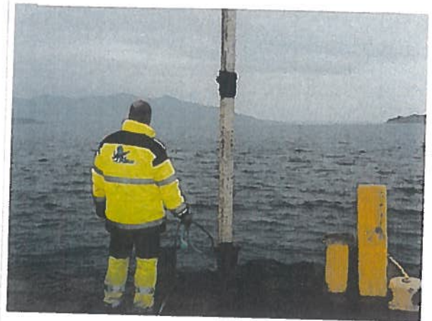
Pele-prøverør monteres mot sjøbunn, klar for nedpeling
