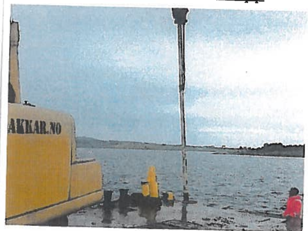
Pele-prøverøret slås ned i sjøgrunnen, inntil full stopp
