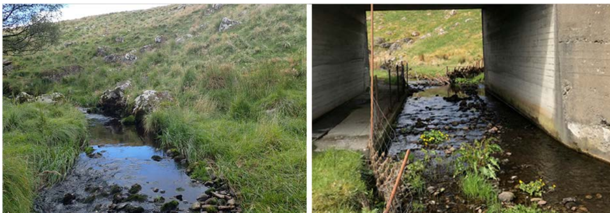
Figur 6-12: Bekk fra Lauvtjørna før og etter kulvert under dagens E39.
