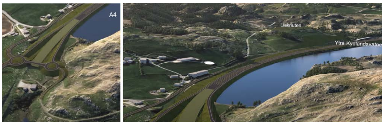
Figur 6-1: Venstre: Bekk fra Runatjørn vil delvis bli lagt i rør under krysset på Bue. Høyre: Veien går på fylling i Ytra Kydlandsvatnet.
