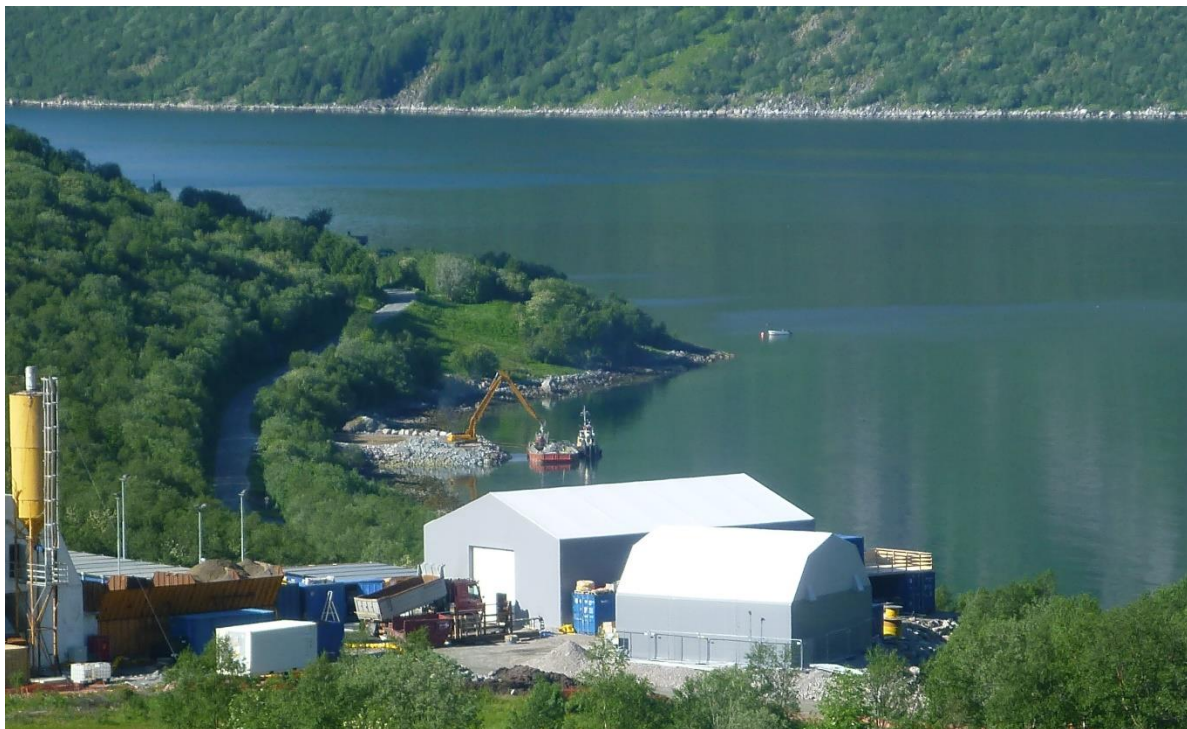
Figur 8: opplasting av tunnelmasser fra testsalve i Aldersundet
