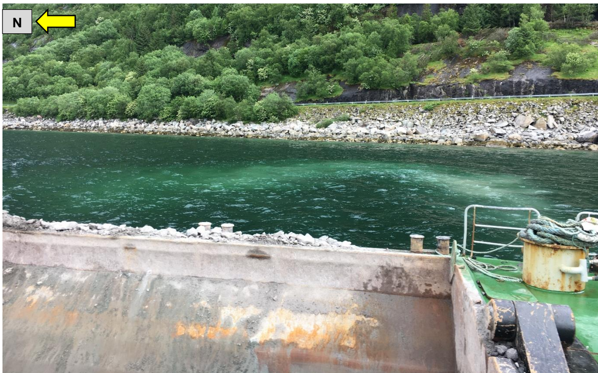
Figur 12: Partikkelspredning i overflaten mot sørvest rett etter dumping av tunnelmasser fra lekker ved «Tipp 1».
