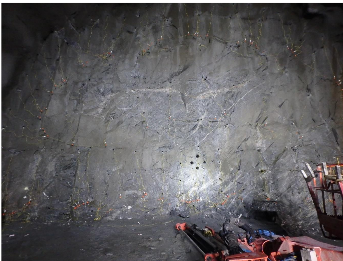
Figur 3: Ferdig ladet stoff, alle koblingsboksene er koblet til samme wire. Testsalve 2.
