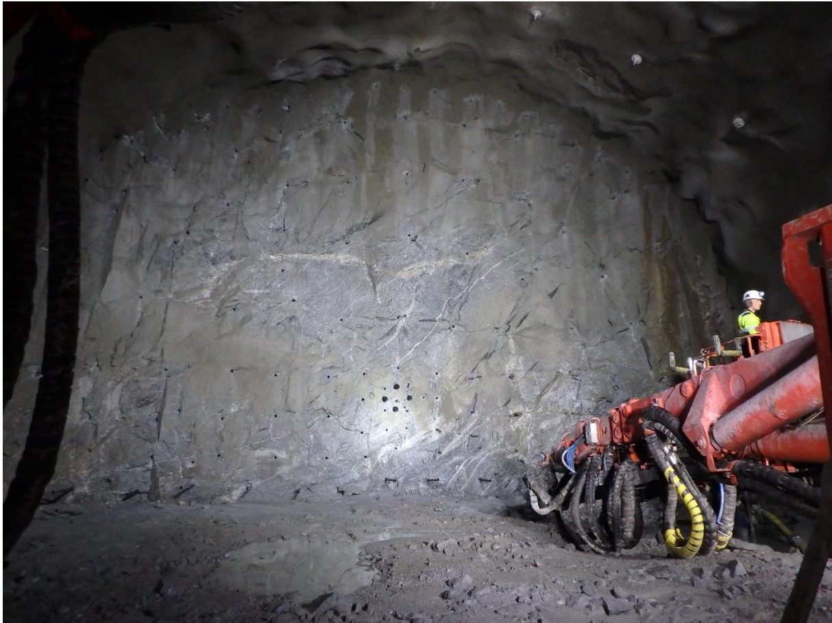
Figur 1: Ferdigboret stuff klar for lading med elektroniske tennere – testsalve 2
