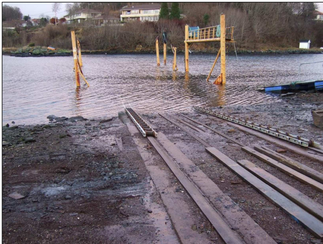
Figur 20. Vannkanten av slippområdet. Det er ingen fast dekkflate over jordmassene ved vannkanten.
