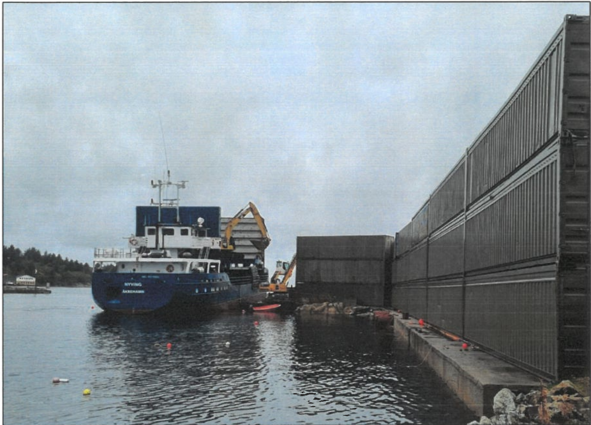
Figur 4-3: Deler av containerveggen som skjerner mot Veavågen, sett fra sjøsiden.
