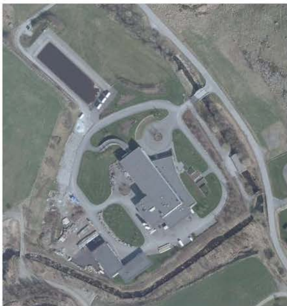
Figur 8-8: Ortofoto fra eksisterende vannbehandlingsanlegg med relativt store sammenhengende grøntarealer.
