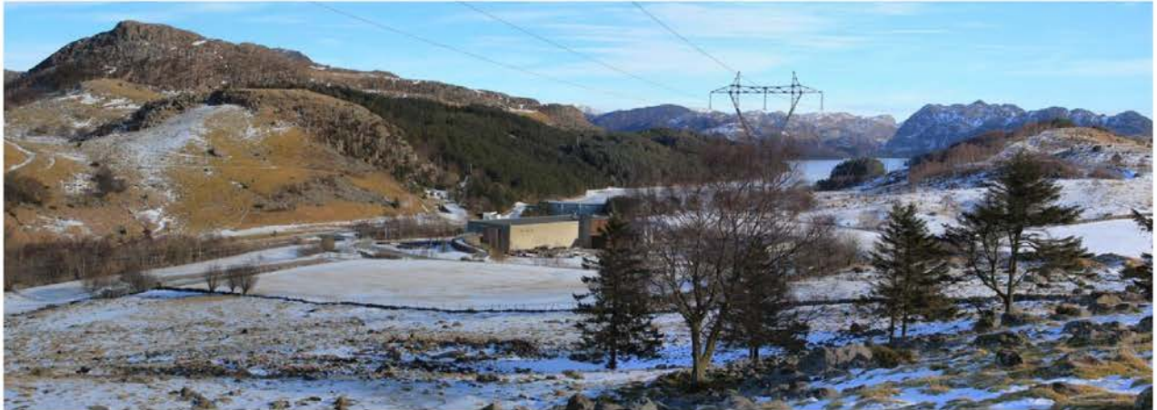
Figur 8-11: Foto fra dagens vannbehandlingsanlegg. Bildet er tatt fra skråning i vest (fotopunkt2).
