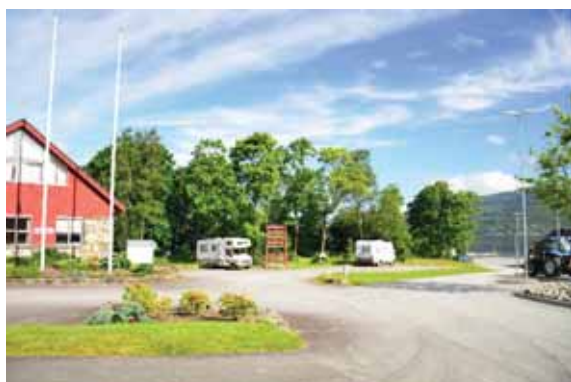
Figur 13 Parkeringsplasser ved friluftsområdet.
