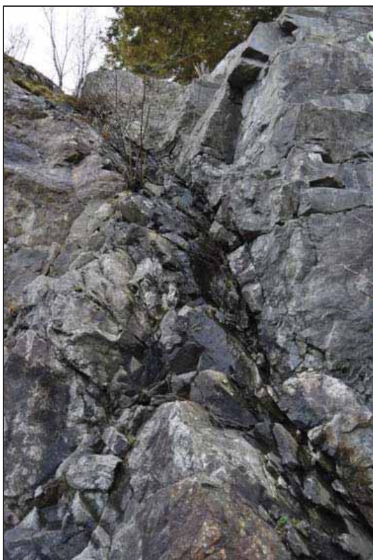
Bilde 6. Sprekkesone ved ca. profil 80.
