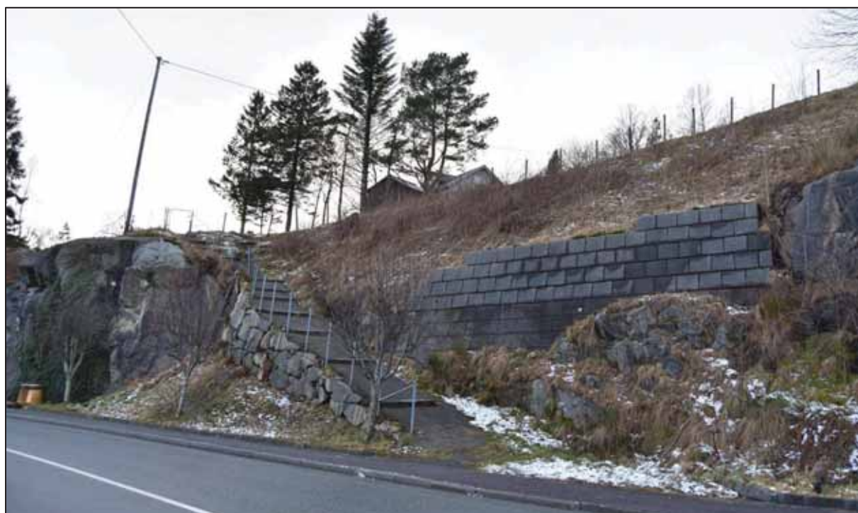
Bilde 8. Dagens skjæring med stien som går opptil marka. Mellom ca. profil 130 og 150 er skjæringen sikret med tørrmur over berg.
