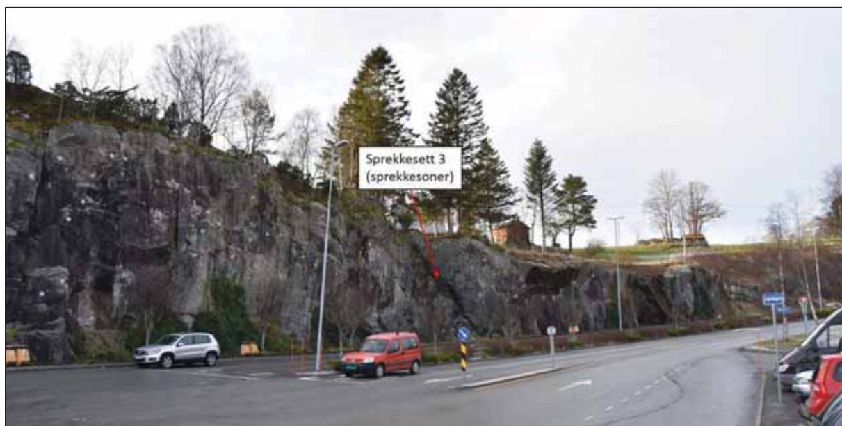
Bilde 4. Dagens bergskjæring sett fra ca. profil 50 til stien opp til marka ved ca. profil 140.
