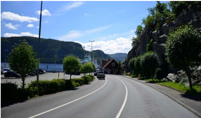
Figur 10 Dagens situasjon. Biloppstillingsplass med kiosk med venterom og toaletter til høyre og kjøreveg og parkering til venstre.
