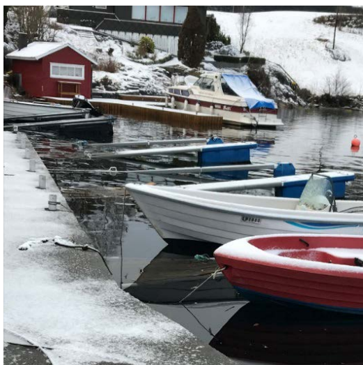
Figur 25: Høyvann ved befaring januar 2018. Man ser at festepunktet til uttriggerne ligger under vann.
