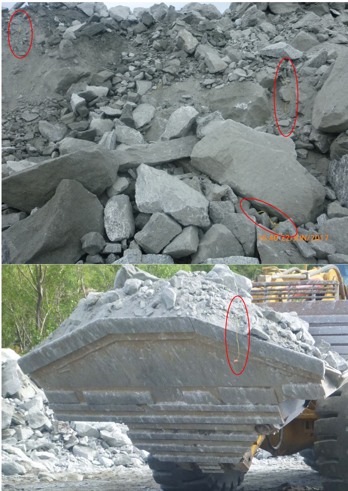
Figur 7: Rester av skyteledning i tunnelmasser
