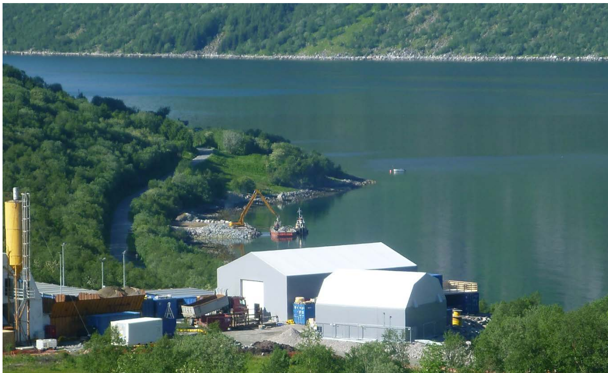
Figur 8: opplasting av tunnelmasser fra testsalve i Aldersundet
