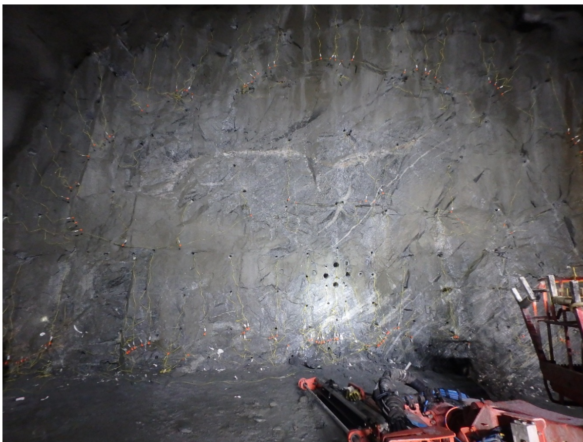
Figur 3: Ferdig ladet stuff, alle koblingsboksene er koblet til samme wire. Testsalve 2.
