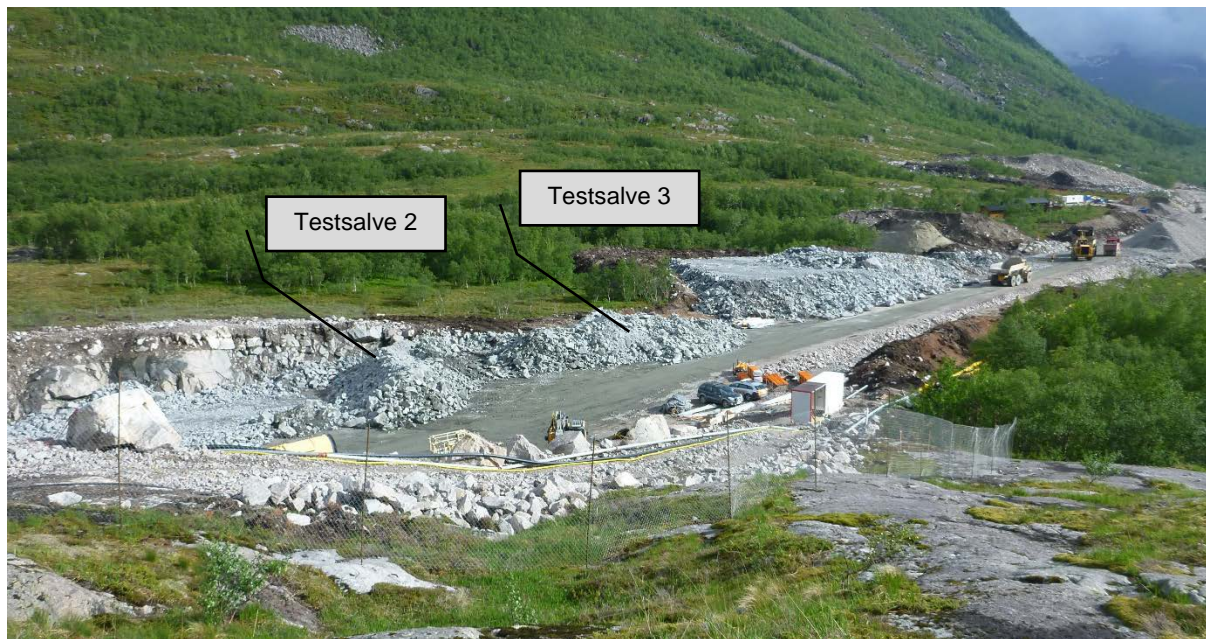
Figur 6: Riggområdet utenfor tunnel for mellomlagring av masser fra de ulike testsalvene. Her vises masser fra testsalve 2 og 3.
