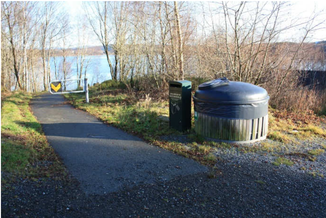
Ved parkeringsplassen er det gravd ned søppelstasjon (molok).
