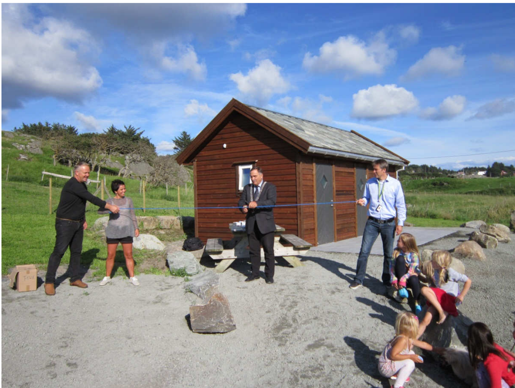
Til sesongen 2012 ble det nye servicebygget innviet. Her er det to adskilte toalettrom, der ett er avsatt til funksjonshemmede.
